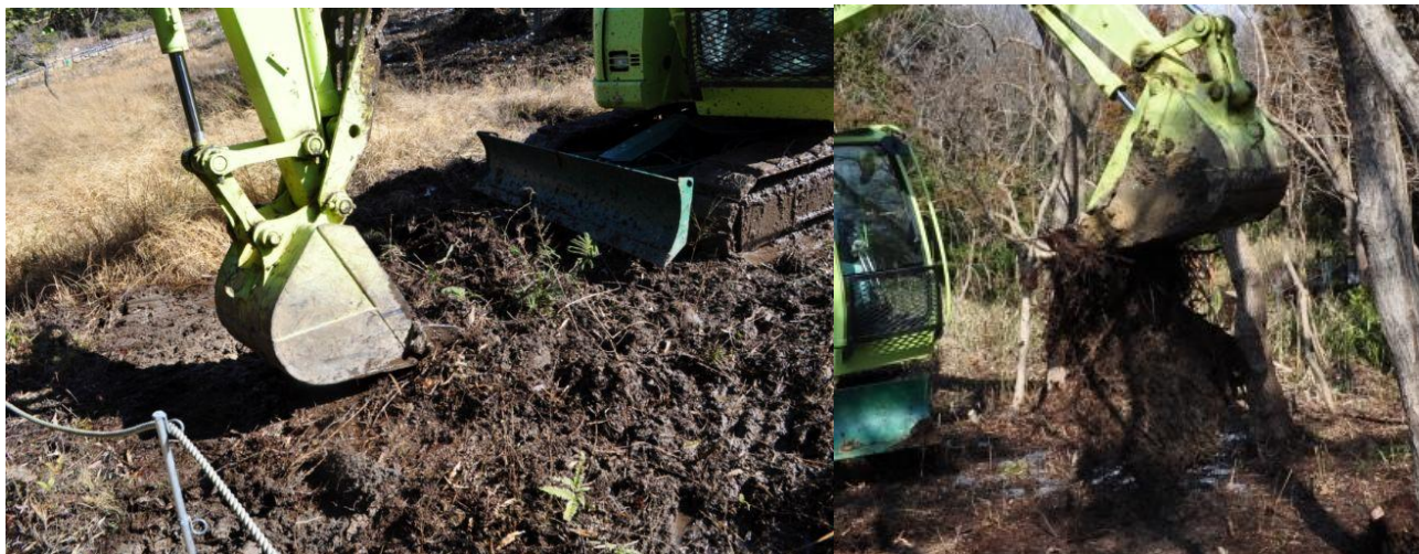
バックホーによる作業（左：ネザサの根の剥ぎ取り、右：伐根）
