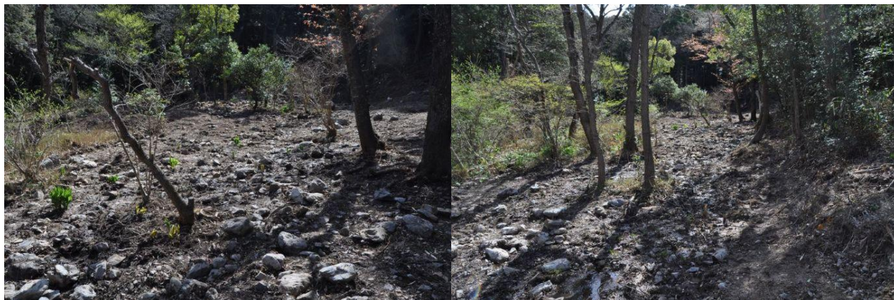
L 地点東作業直後 （2023 年 3 月 22 日）
