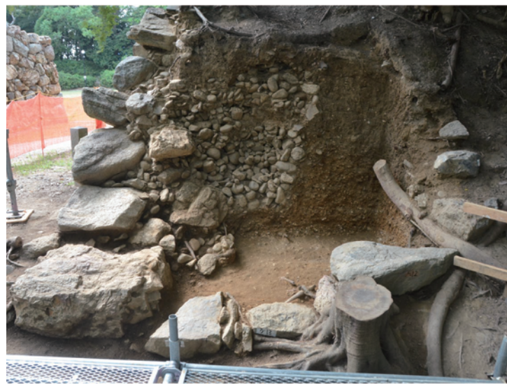
④裏門北側石垣の東面（解体後）
