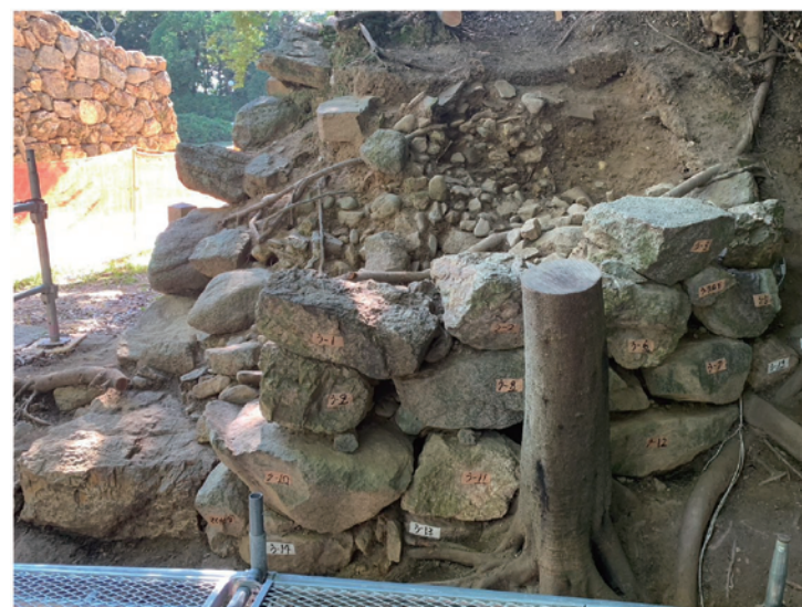
②裏門北側石垣の東面（解体前）
