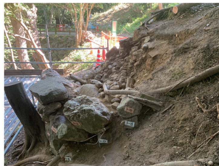
③裏門北側石垣の北面（解体前）
