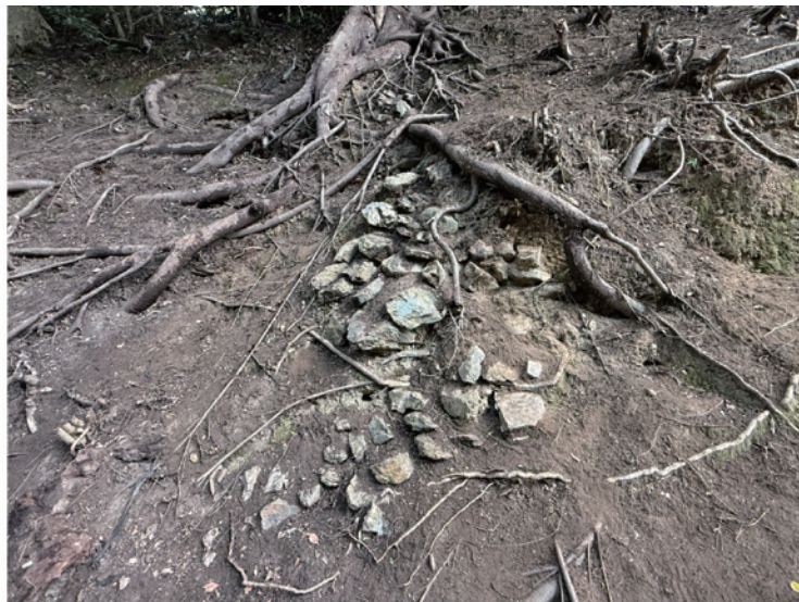
②解体石垣南側の土羽に露出した裏込め石
