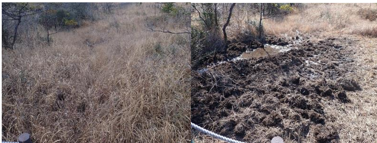
I 地点作業前 （北から：2025 年 1 月 29 日） I 地点作業中 （北西から：2025 年 2 月 26 日）
