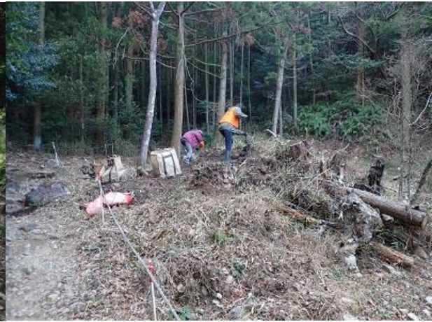
作業中：北から（2024年1月23日）
