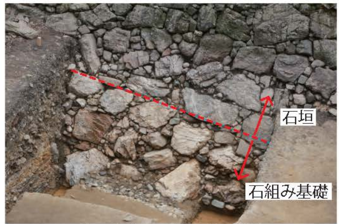
⑤ 鉄櫓下石垣の基礎構造
