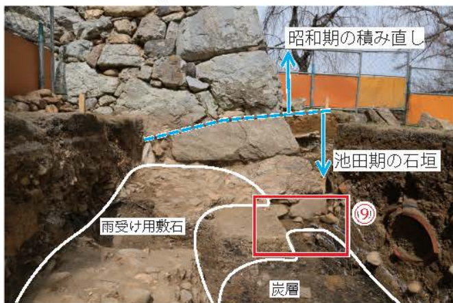
⑧ 鉄櫓台南東部南面の石垣下部
