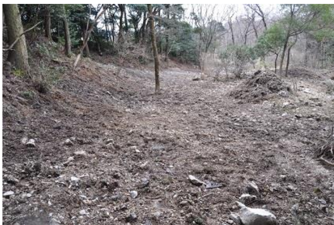
上流部作業直後（南東から：2023年3月1日）
