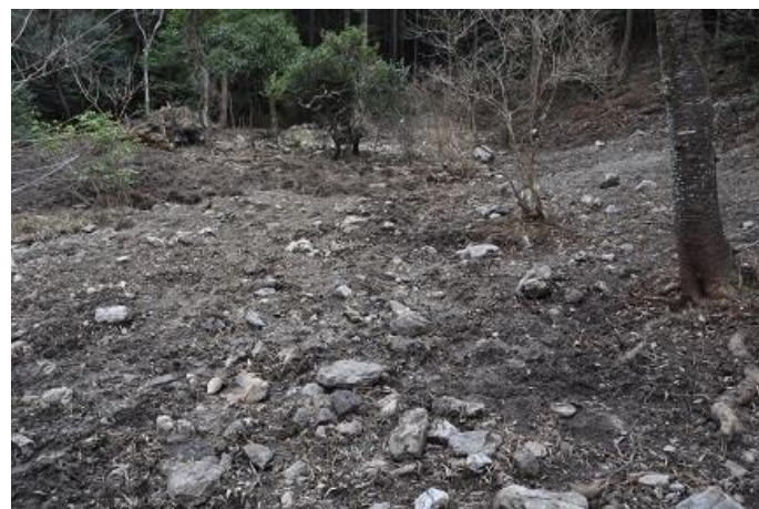
上流部作業直後（北西から：2023年3月1日）
