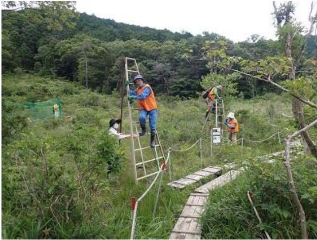
支柱設置作業（2023年6月20日）
