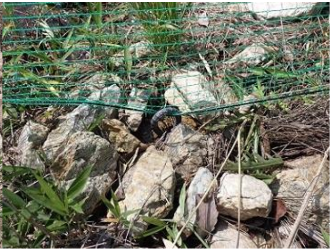
アンカー設置状態（2023年6月20日）
