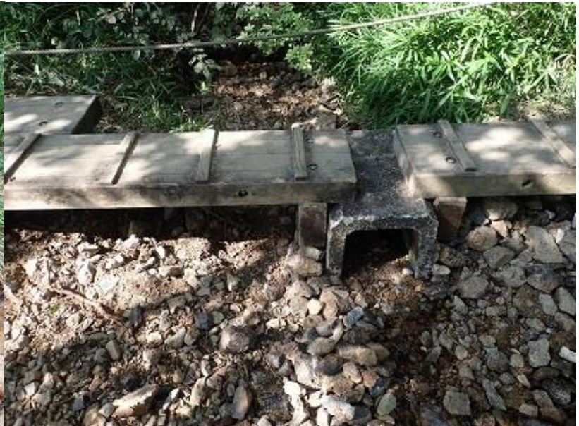
復旧した水路分岐部 （2023年6月20日）
