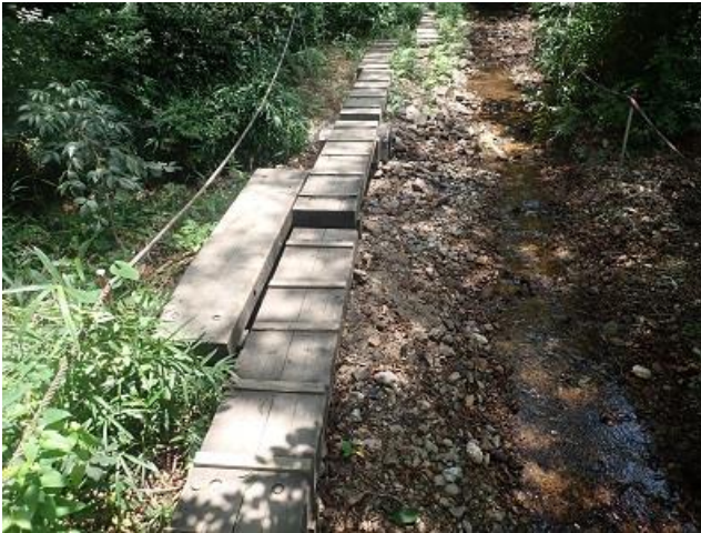
復旧した水路分岐部：西から （2023年7月12日）
