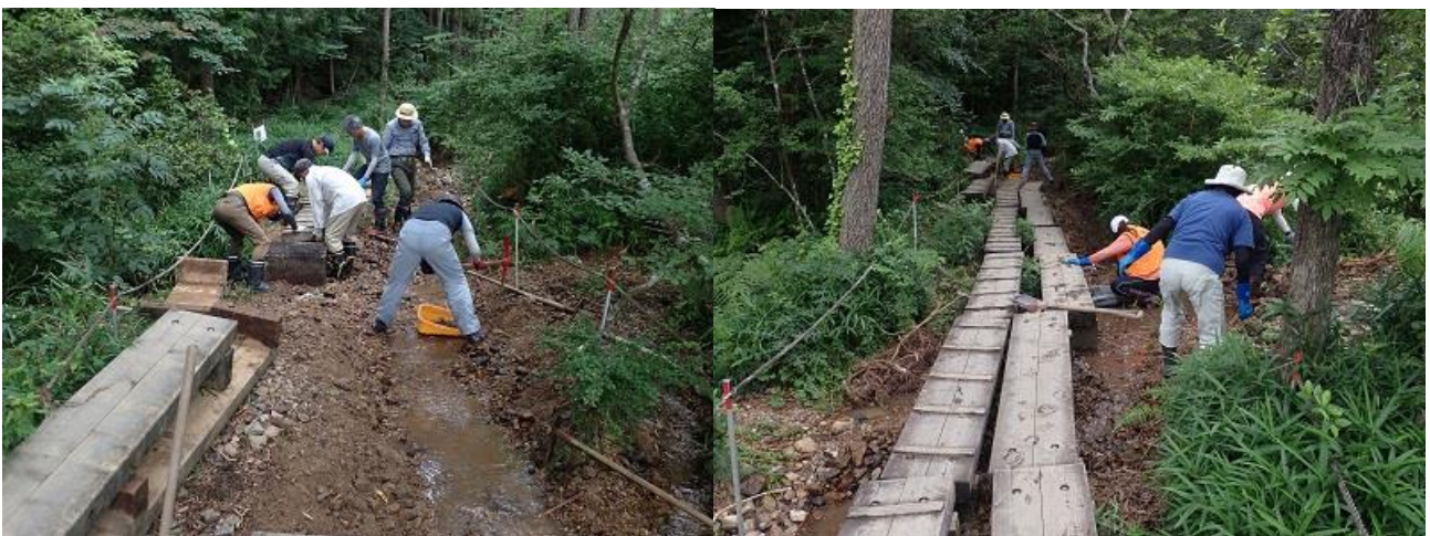
水路の掘削・復旧作業(2023年6月20日)
