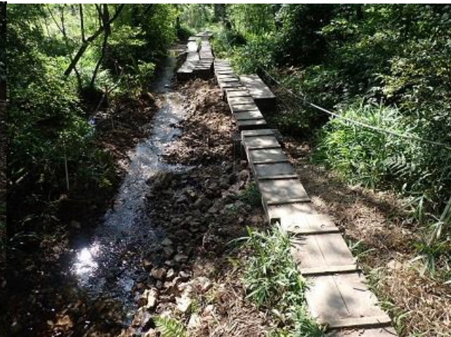
復旧した水路分岐部：東から
