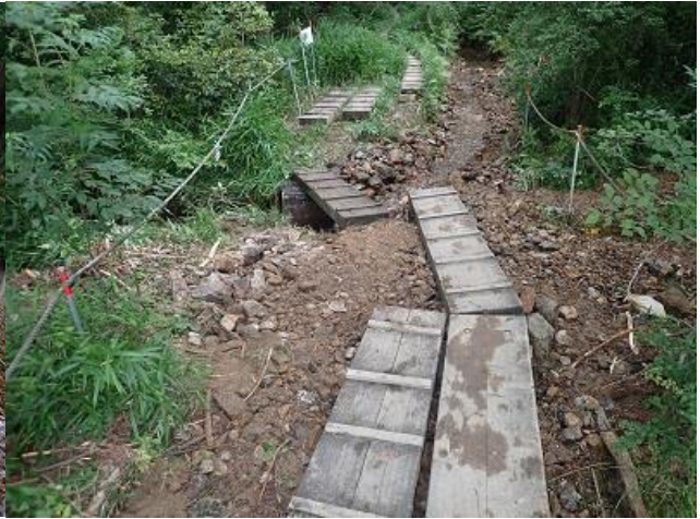
仮復旧した水路分岐部 （2023年6月6日）
