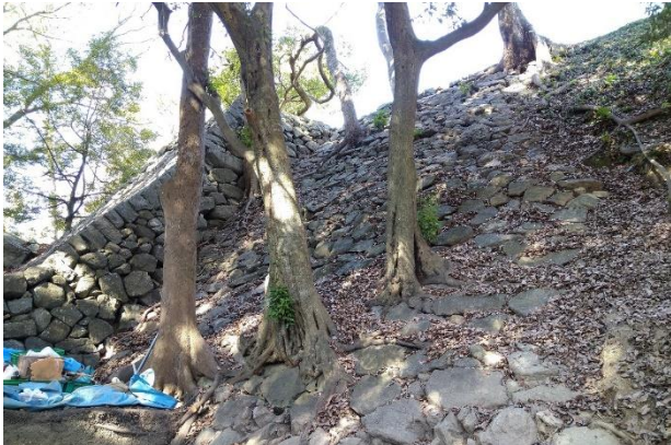
石垣面に生育する樹木（南多門堀石垣）
