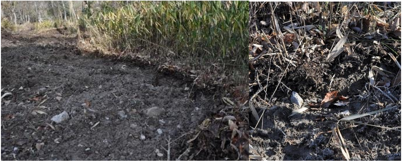
ネザサの根（厚さ約 15 cm）の除去後状況
