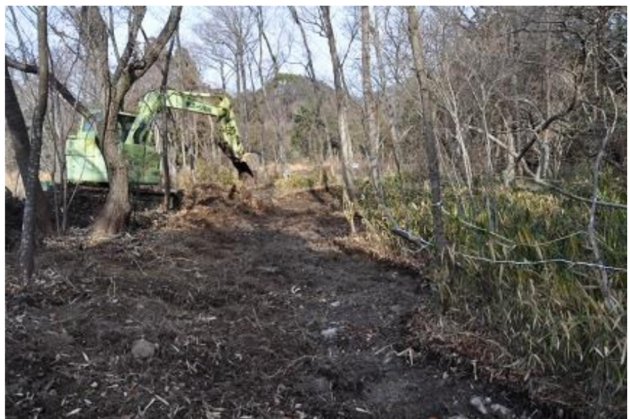
L 地点下流部の根の除去作業一 1（2023 年 1 月 13 日）
