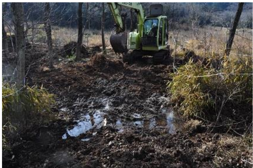
L 地点下流部の根の除去作業一 2（2023 年 1 月 13 日）
