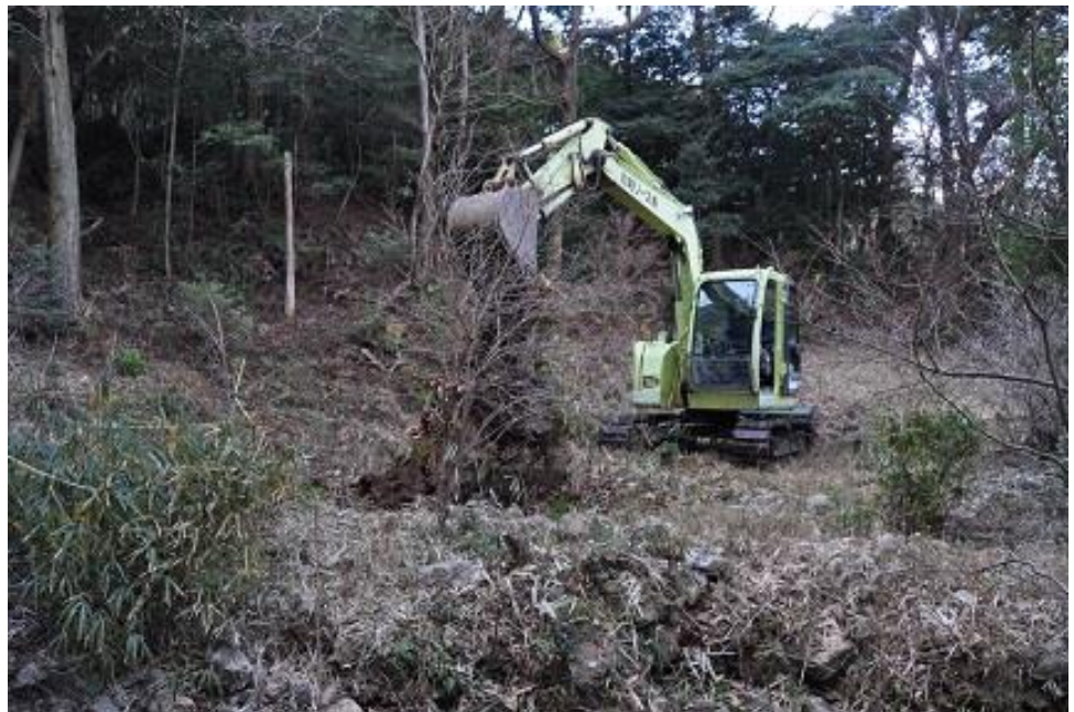
切り株の伐根作業
