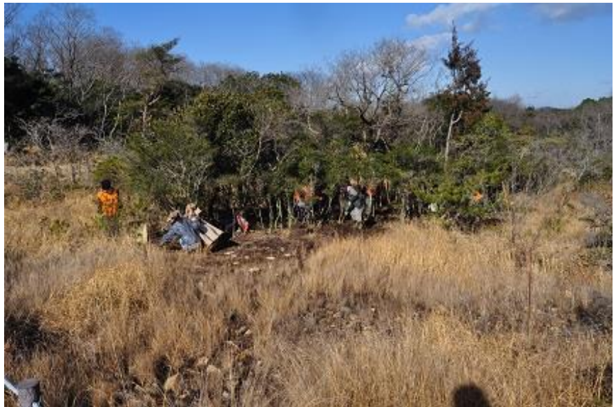
I 地点作業中 (2022 年 2 月 1 日)
