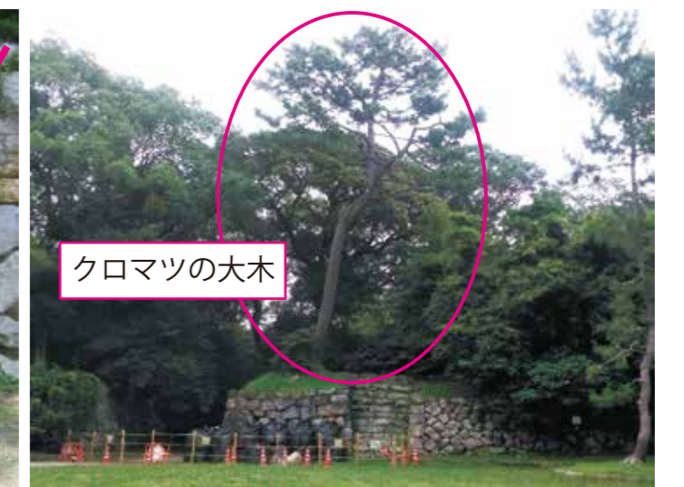
・石垣直上に生育していたクロマツの大木。長年の過重や、樹根による侵食で石垣に損傷が蓄積し、最終的に大雨で崩落した。この崩落をきっかけに吉田城址の石垣保護の取り組みが始まり、令和元年10月にはこのクロマツを含め、石垣上の大木伐採による負荷軽減が図られた。
