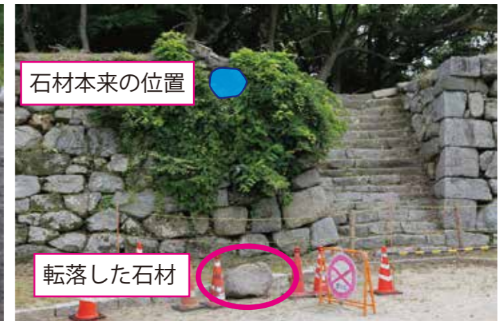
・石材転落時の状況。フジが繁茂し、石垣を覆い隠している。こうした状態では、転落する前に危険を予知することはできない。
