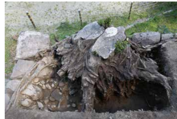
・発掘調査を終えた際の状況。調査前は一面が根に覆われていた。長く伸びた樹根が石材を覆ったり、背面から動かしていることが分かる。
