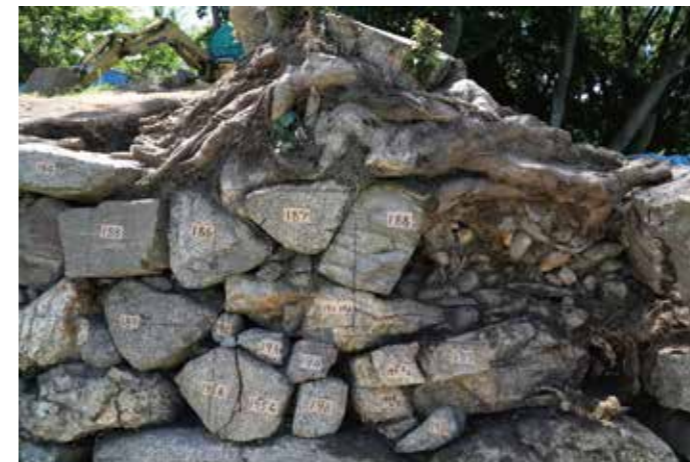
左：石垣を侵食しながら成長した樹木の状況 右：左の写真の色付けし解説したもの。石垣上部に生育していたモチノキが、石垣を圧迫するだけでなく、荷重によって石材そのものが割れてしまうなど、様々な問題の原因となっていたことが分かる。
