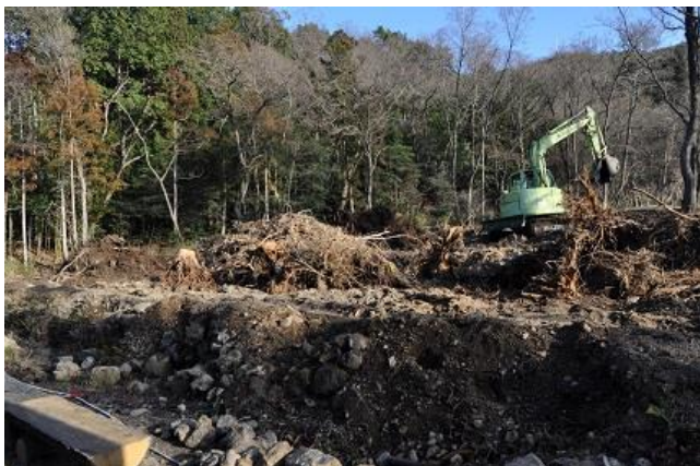
抜根作業（2021年2月2日）
