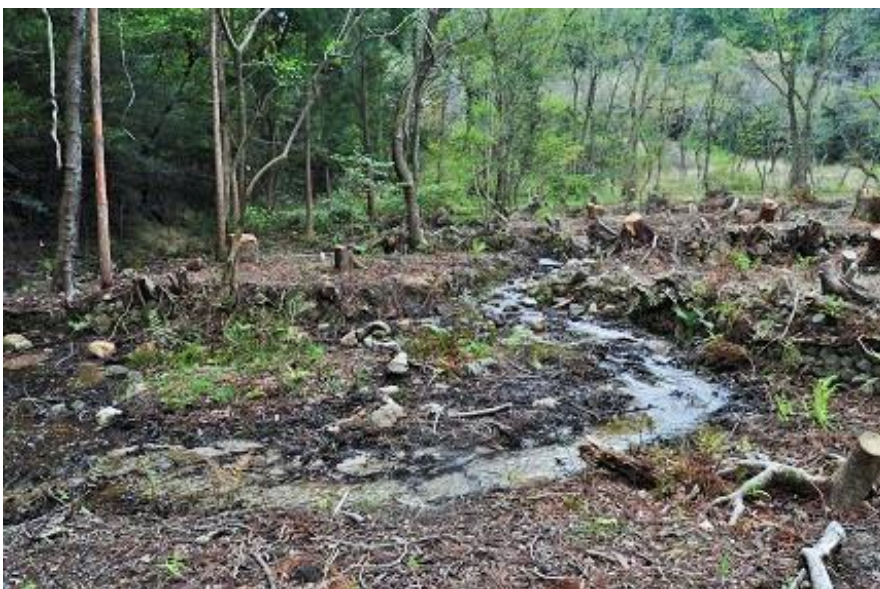
P地点北側伐採作業後（2020年4月2日）
