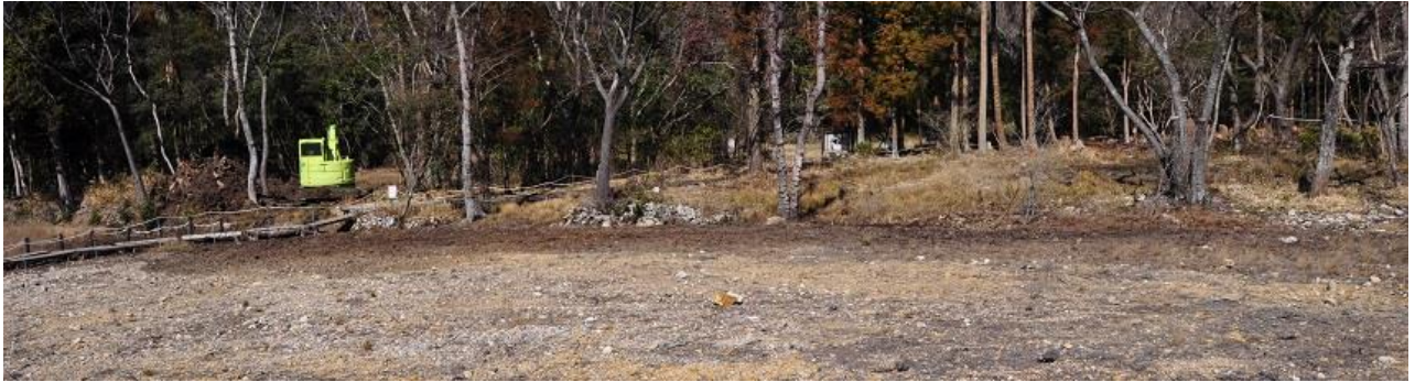
P 地点仮置きした根の山除去後 （2020 年 2 月 27 日）
