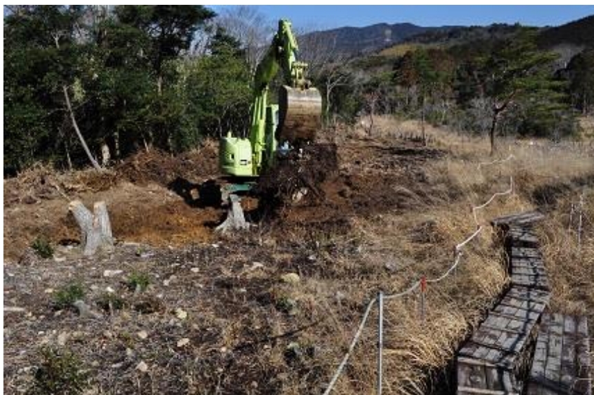
H地点バックホーによる抜根作業（2019年3月5日）
