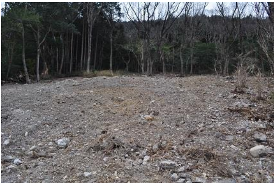
T・U地点抜根作業後 (2019 年 3 月 19 日)
