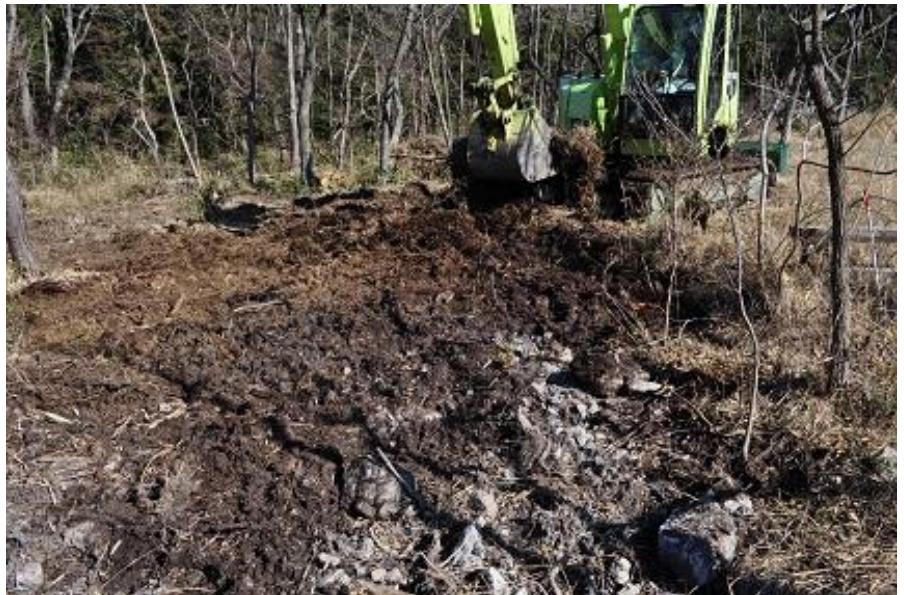
L地点抜根作業（2019年3月8日）
