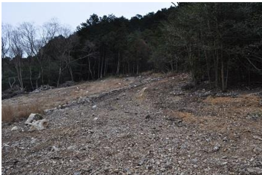
S地点抜根作業後（2019年3月19日）
