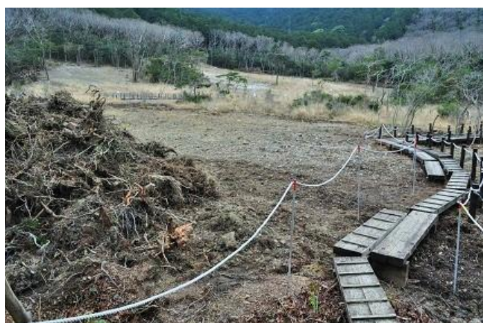
P 地点北側・抜根後 (2018 年 3 月 19 日)
