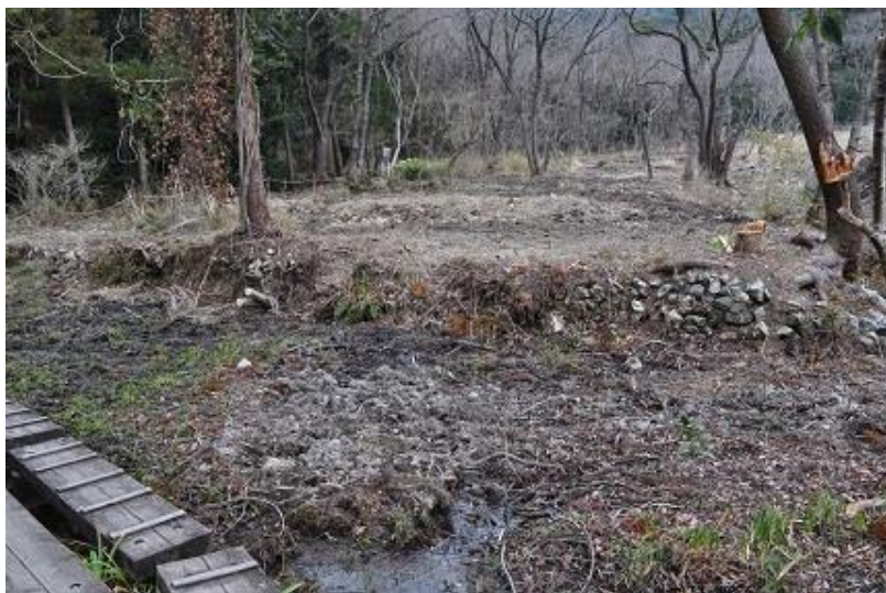
F 地点作業後（北から：2019 年 3 月 19 日）
