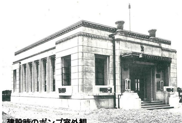
建設時のポンプ室外観
