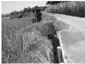
市道脇の水路（井溝）
