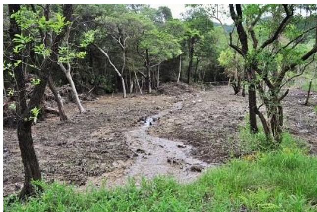
抜根作業後（2018年5月9日：西から）
