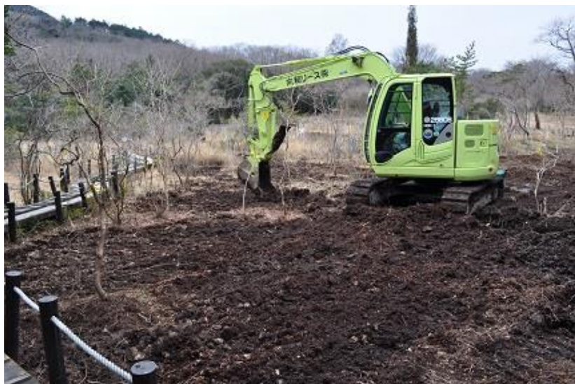
○地点南部作業 中 （2018年2月21日：東から）
