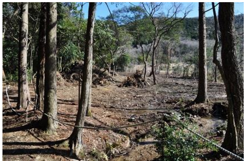
Y地点作業後（2018年3月10日：北から）
