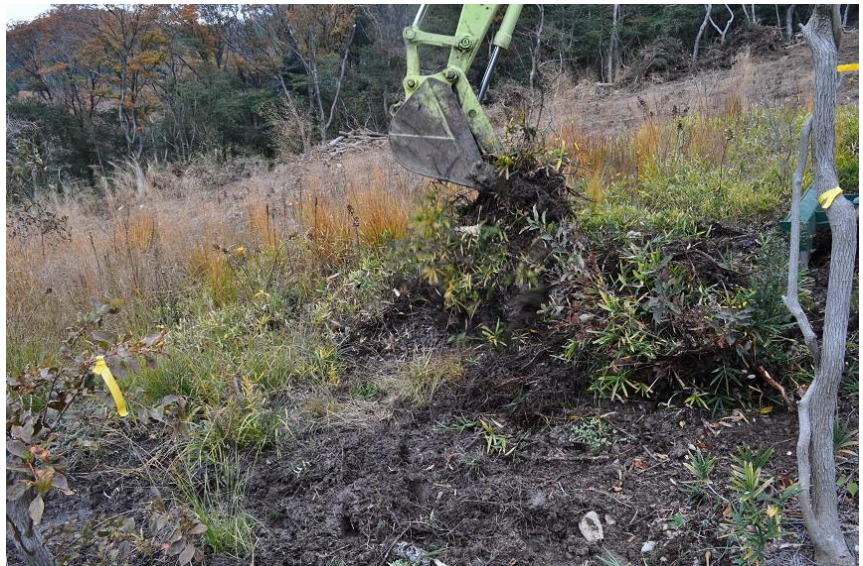
湿地中心部西側のネザサの根の剥ぎ取り作業
