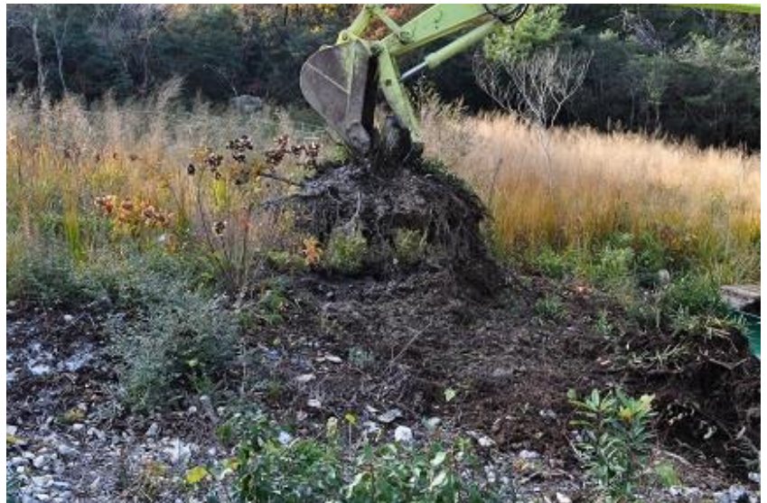
灰色礫層（湿地）での抜根（2017年11月27日）
