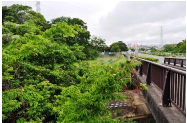
作業後（東から 2017 年 5 月 26 日）
