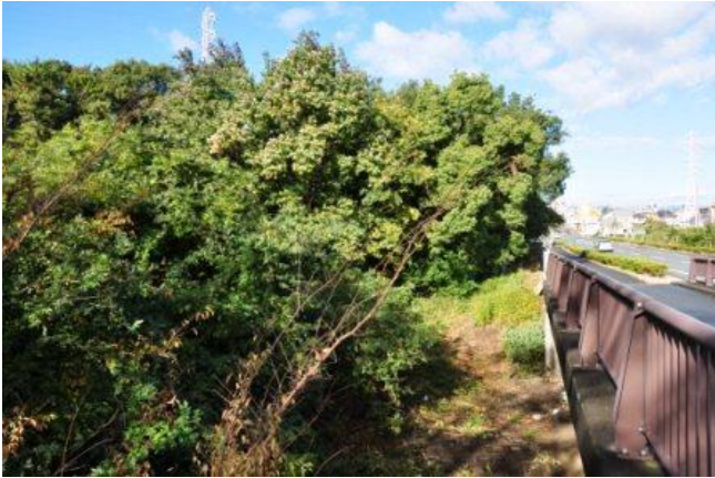
作業前（東から 2016 年 11 月 11 日）
