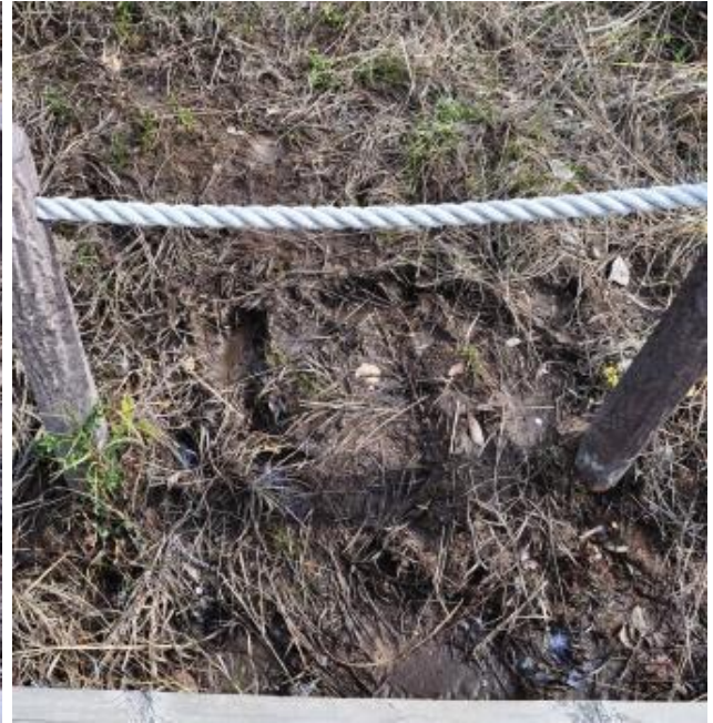
踏み石除去状況
