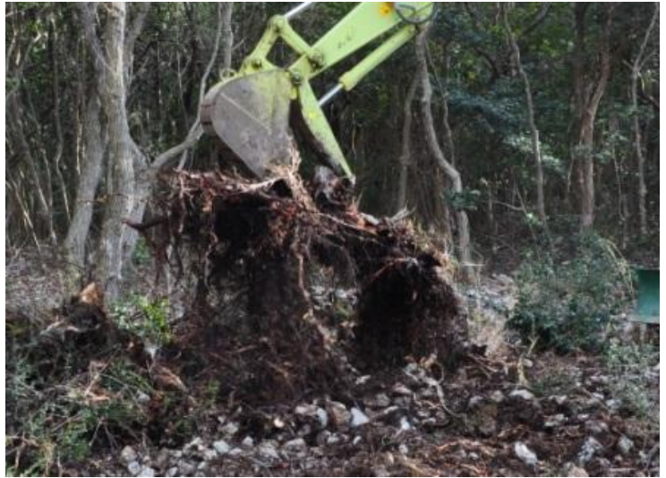
大きな切り株を抜根した(剥がした)ところ 複数の木の根が絡み合いマット状になっている
