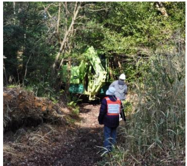
指定地林内の自然歩道を進むバックホー
