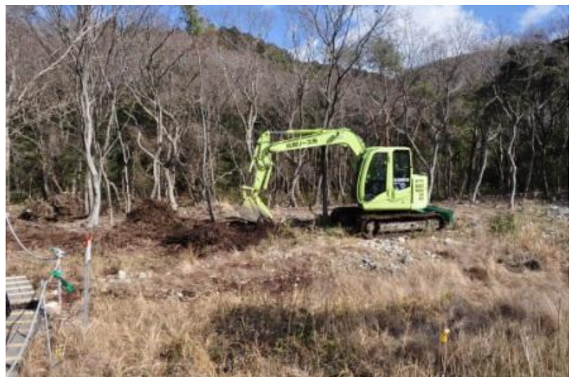
L 地点でスポンジ状になったネザサの根を除去している所
