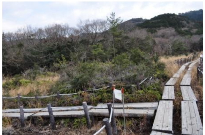
N－1・3地点作業前（西から）
