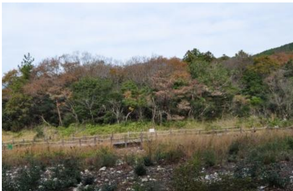
M地点西側作業前（南から）
