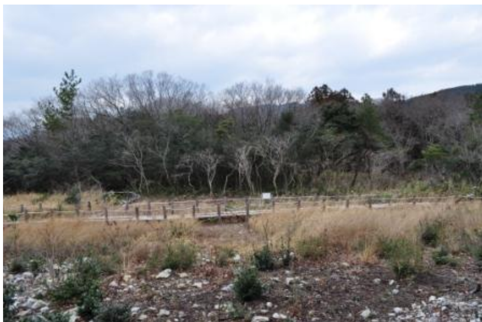
M地点西側作業後（南から）
