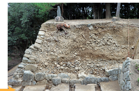
⑭全体の発掘調査完了 石垣基底部の損傷確認のため、断ち割りを行いました。
