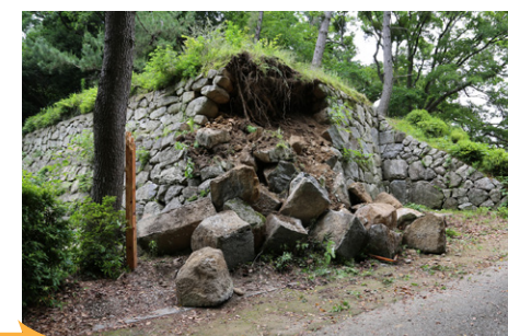
⑧崩落当日の状況（令和3年5月22日） 左図の孕み出しを中心に崩落したことが分かります。
