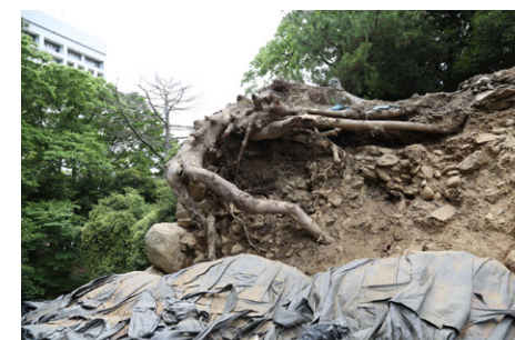
⑧崩落当日の状況（令和3年5月22日） 左図の孕み出しを中心に崩落したことが分かります。
