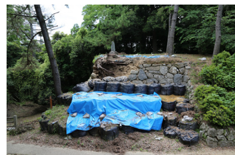
⑩発掘調査開始前の清掃作業の状況（左：遠景、右：石垣上のエノキ樹根の様子） 安全確保及び調査の精度を確保するために、発掘と解体を交互に行うこととしました。
