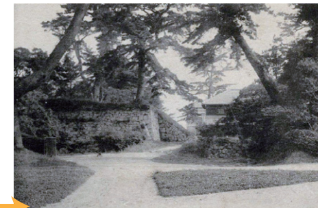
⑤古写真（大正8年以降） 南多門台が崩れています。昭和東南海地震の影響？
